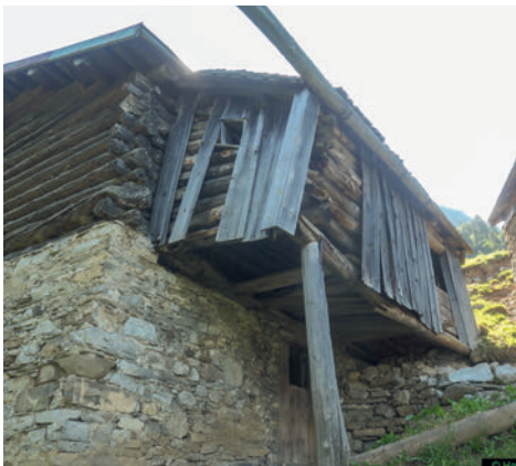
Aebi Stall vor Sanierung
