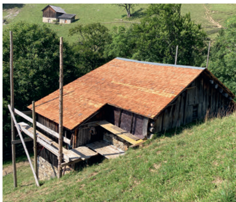
Schärätürli Stall nach Renovation
