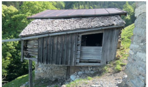
Aebi Stall vor Sanierung
