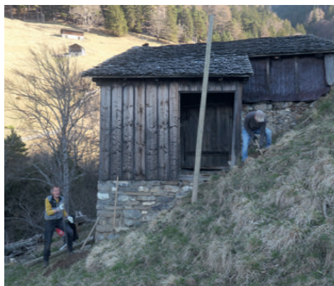
Schärätürli Stall in Renovation
