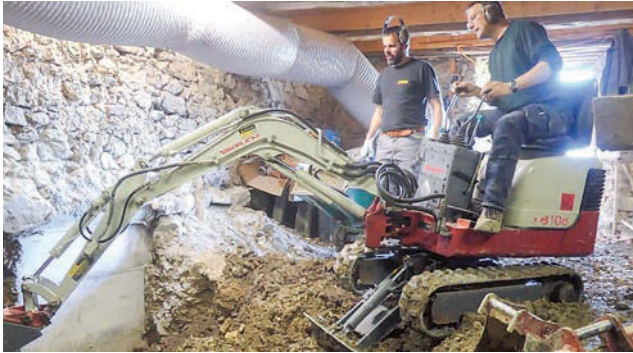
Guschaheimstall Baggerarbeiten Bernhard und Rolf
