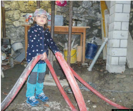
Guschaheimstall Santina unterstützt Bauarbeiten
