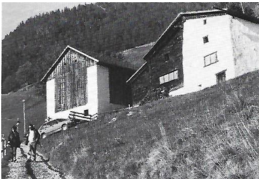
Das Tolenborthaus nach der Renovation durch die "Pro Guscha".
