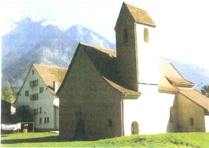
Vorderseite der Gemeindekirche St. Luzisteig, errichtet um 800 n. Chr.
