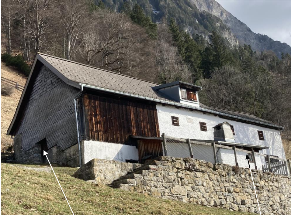
Guschaheim mit Tenn wo die Sanitäranlage eingebaut wird, WC-Häuschen mit Plumpsklo
